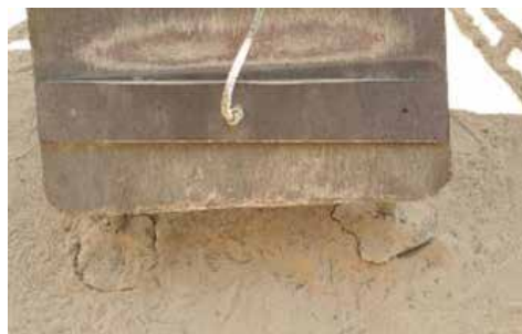
120.,121., 122.attēls. Kompleksā iekārta. Iekārtai bojāti balsta konstrukcijas elementi, kā arī pamati nav nostiprināti atbilstošā dziļumā.
