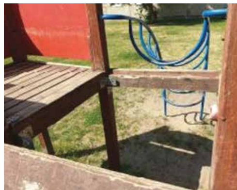
112., 113.attēls. Kompleksā iekārta. Iekārtai trūkst elementi.
