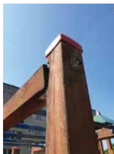
120.,121., 122.attēls. Kompleksā iekārta. Iekārtai bojāti balsta konstrukcijas elementi, kā arī pamati nav nostiprināti atbilstošā dziļumā.
