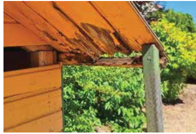
126., 127., 128.attēls. Mājiņa. Iekārtai trūkst sastāvdaļu un daļa koka elementu ir bojāti.
