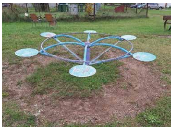
95., 96.attēls. Karuseļi Karuseļu sēdekļi nav nodrošināti ar rokturiem vai muguras balstu.
