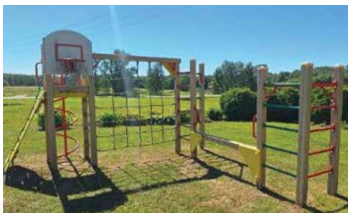
107., 108.attēls. Kompleksā iekārta. Basketbola groza un kāpelēšanas elementa ietekmes zonas būtiski pārklājas.
