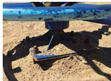
129., 130., 131.attēls. Karuselis. Iekārtai trūkst grīdas elementu, kā arī pamati nav nosegti.
