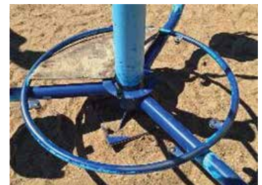
129., 130., 131.attēls. Karuselis. Iekārtai trūkst grīdas elementu, kā arī pamati nav nosegti.
