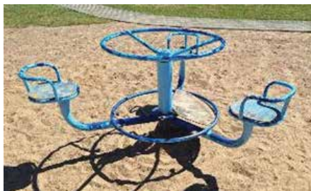
129., 130., 131.attēls. Karuselis. Iekārtai trūkst grīdas elementu, kā arī pamati nav nosegti.
