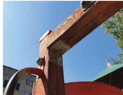
117.,118.,119.attēls. Kompleksā iekārta. Remonta procesi nav veikti saskaņā ar ražotāja instrukcijās noteikto.
