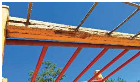
132., 133., 134.attēls. Kāpelēšanas konstrukcija. Iekārtai bojāti balsta konstrukcijas elementi.
