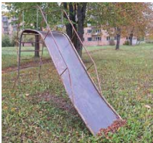
99.attēls. Slīdkalniņš Nedrošas konstrukcijas slīdkalniņš - nav nobeiguma daļas, nav sānu aizsardzības.
