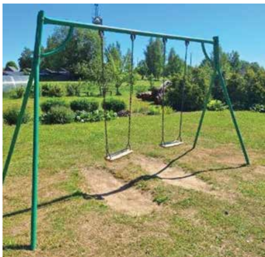
103.attēls. Šūpoles. Neatbilstošs triecienu mazinošais segums – bojāts zāliens un cieta augsnes virskārta (krišanas augstums lielāks par 1 m).
