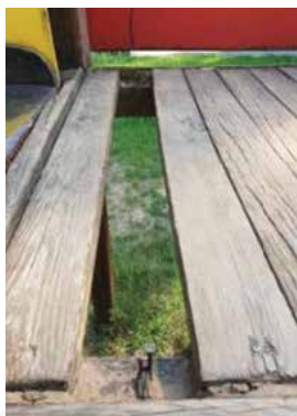
114., 115., 116.attēls. Kompleksā iekārta. Iekārtas elementiem trūkst sastāvdaļu, kā arī ir izvirzītas naglas.
