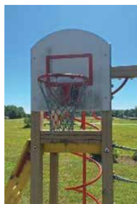
107., 108.attēls. Kompleksā iekārta. Basketbola groza un kāpelēšanas elementa ietekmes zonas būtiski pārklājas.
