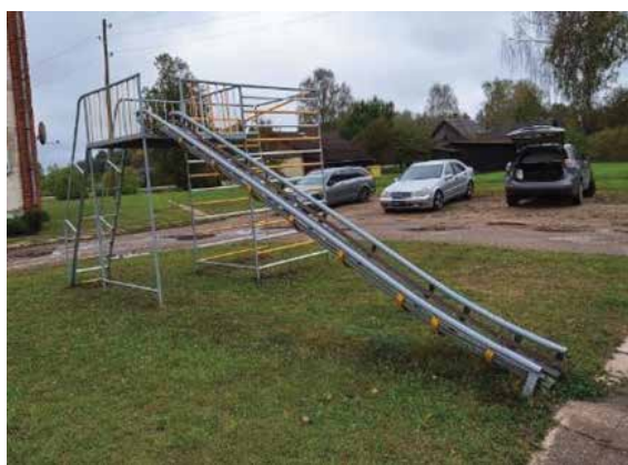
97., 98.attēls. Kompleksā iekārta. Iekārtas konstrukcijas elementos pastāv galvas iesprūšanas risks (viegli pieejami iekārtas elementi), nedrošas konstrukcijas slīdkalniņš (nav šķērsstienis, nav nobeiguma daļas, slīdēšanas virsmā atvērumi), slīdkalniņa ietekmes zonā betona celiņš (neatbilstošs triecienu mazinošais segums).
