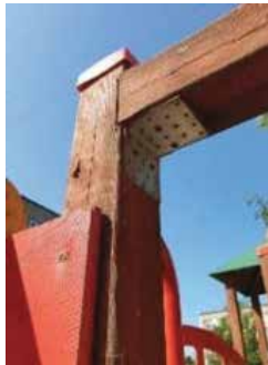
117.,118.,119.attēls. Kompleksā iekārta. Remonta procesi nav veikti saskaņā ar ražotāja instrukcijās noteikto.
