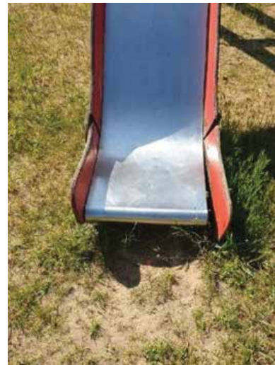
123., 124., 125.attēls. Slīdkalniņš. Iekārtai trūkst vairāki pakāpieni, kā arī nobeiguma daļas sānu aizsardzība ir sadalījusies.
