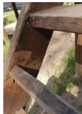
114., 115., 116.attēls. Kompleksā iekārta. Iekārtas elementiem trūkst sastāvdaļu, kā arī ir izvirzītas naglas.
