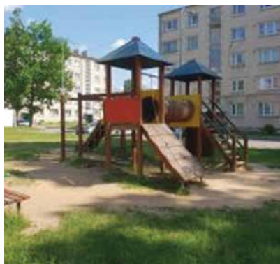
114., 115., 116.attēls. Kompleksā iekārta. Iekārtas elementiem trūkst sastāvdaļu, kā arī ir izvirzītas naglas.
