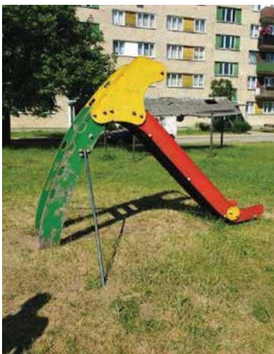
123., 124., 125.attēls. Slīdkalniņš. Iekārtai trūkst vairāki pakāpieni, kā arī nobeiguma daļas sānu aizsardzība ir sadalījusies.
