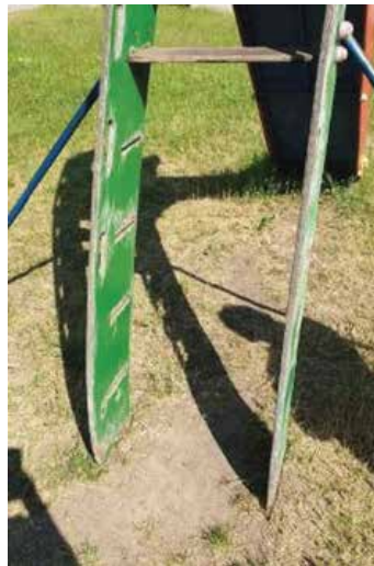
123., 124., 125.attēls. Slīdkalniņš. Iekārtai trūkst vairāki pakāpieni, kā arī nobeiguma daļas sānu aizsardzība ir sadalījusies.
