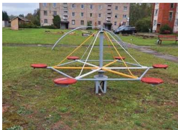
95., 96.attēls. Karuseļi Karuseļu sēdekļi nav nodrošināti ar rokturiem vai muguras balstu.
